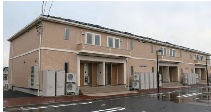
アパート新築工事
