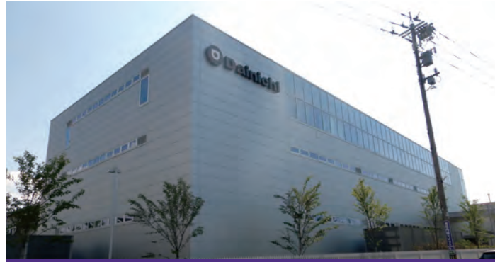
株式会社大日製作所新築工事
